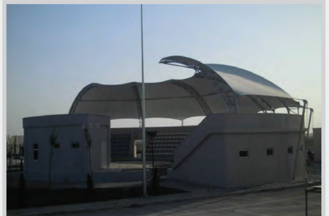
AMFİ TİYATRO UYGULAMASI TÜRKMENİSTAN
