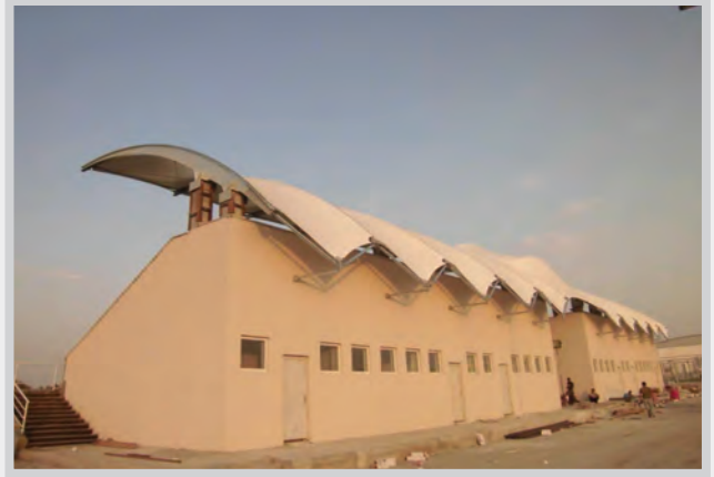
TRİBÜN UYGULAMASI TÜRKMENİSTAN
